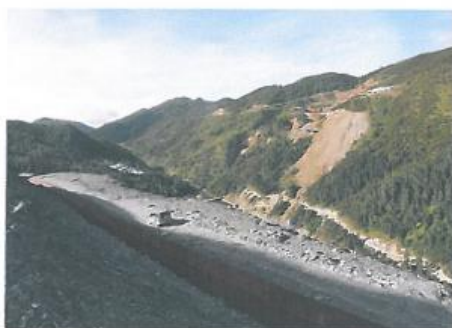
东侧中段 5mm 钢板水槽
