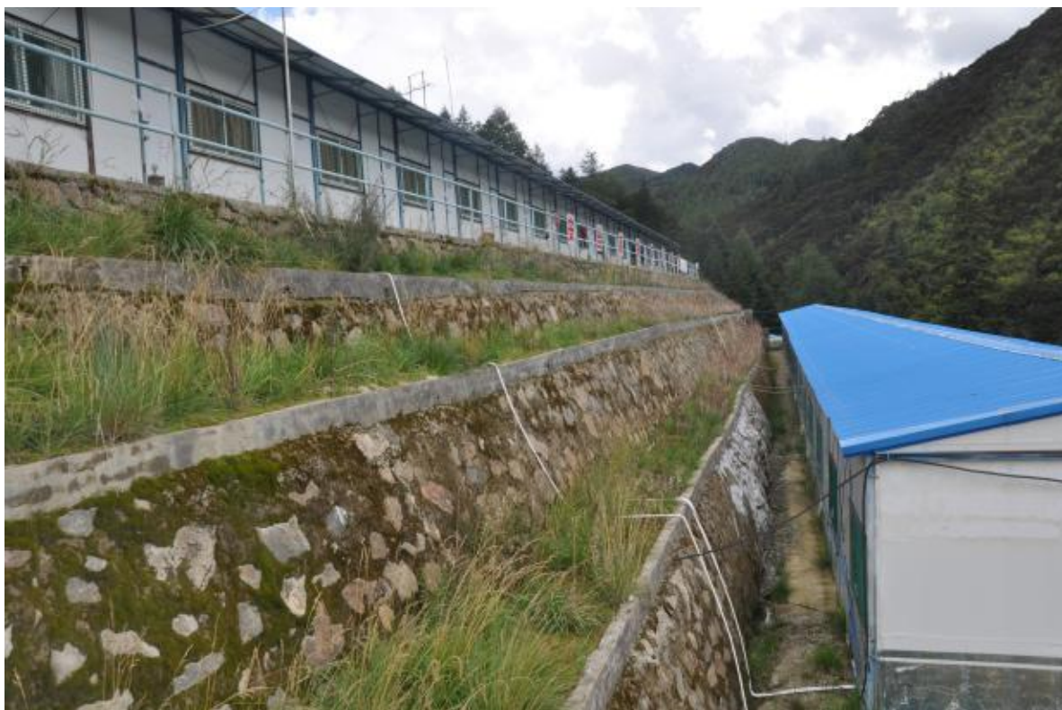
行政福利区-绿化、护坡工程（2014.9）
