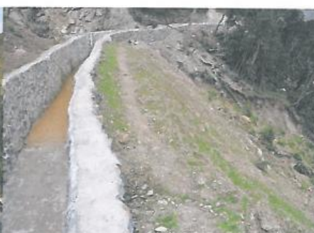
西侧浆砌石截排水沟
