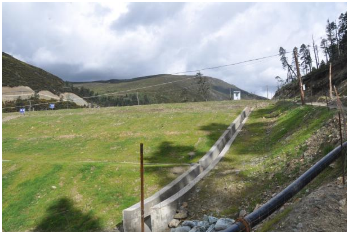
尾矿库区-排水（2014.9）
