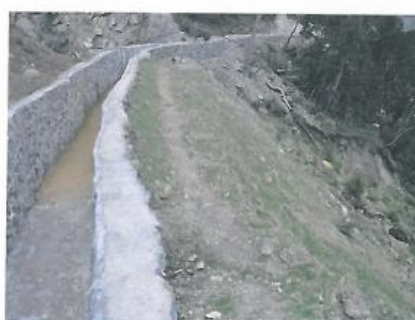
西侧浆砌石截排水沟
