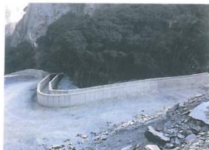
东侧北段钢筋混凝土截排水沟
