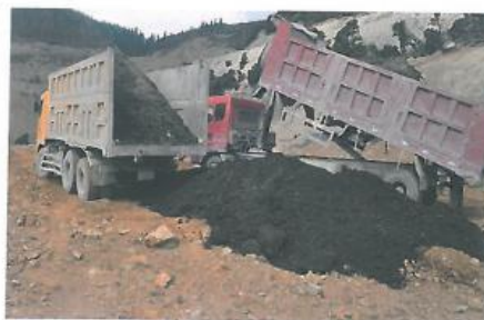
如米沟排土场渣体覆土现场
