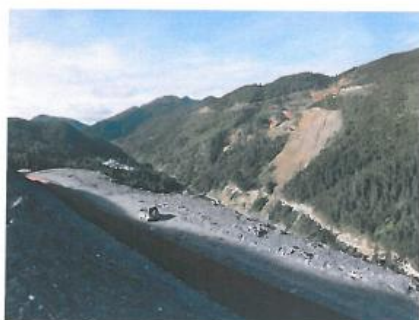
东侧中段 5mm 钢板水槽
