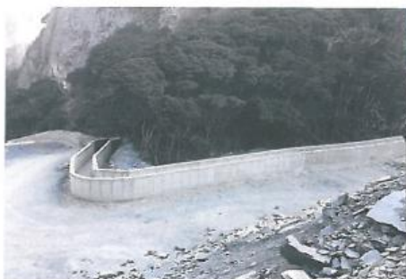
东侧北段钢筋混凝土截排水沟
