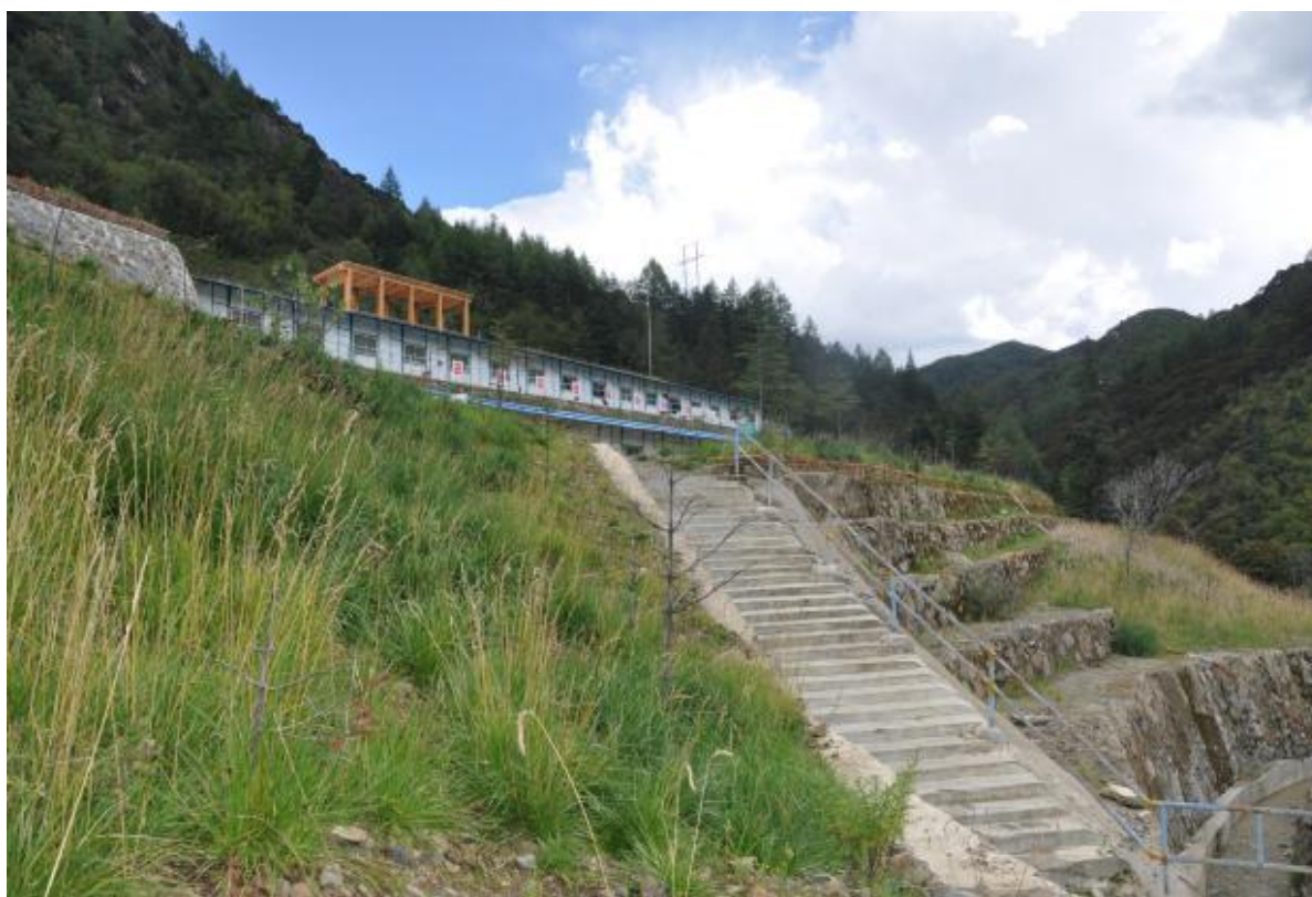
行政福利区-绿化、护坡工程（2014.9）
